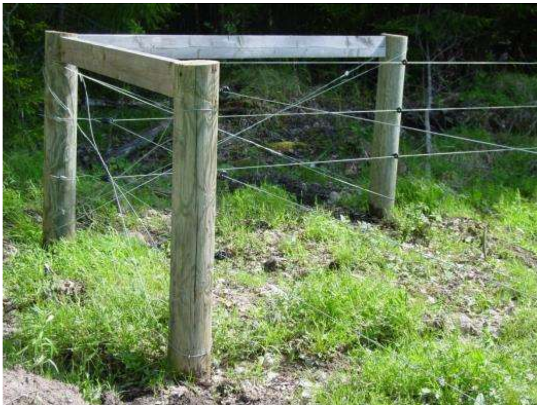
KUVA 2. High Tensile-aidan kulmarakenne (Vehkaoja, s.a.)
