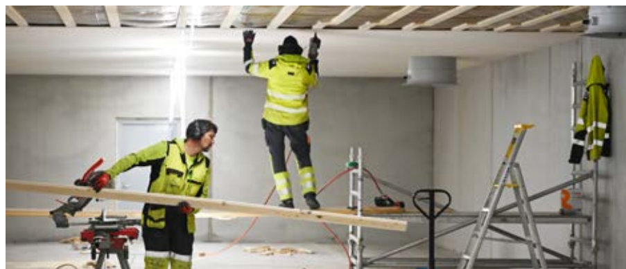
Byggstaff monterar innertak i den avdelning som färdigställs under våren.
