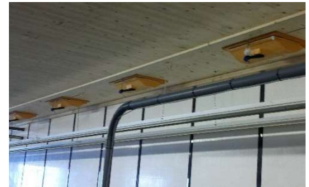
Tuloilmaluukut tulee tarkistaa, että ne aukeavat kaikki tasaisesti
